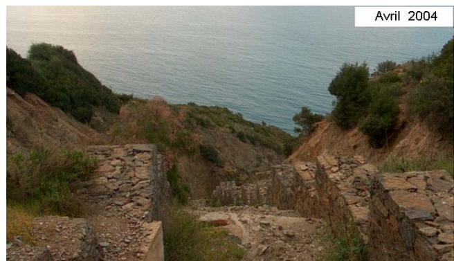
Photo 3 : Accélération de l'érosion hydrique en aval d'un ouvrage en gabion implanté pour protéger la route côtière sur les pentes de la racine du Cap Targha (photo, F. Charfi).
