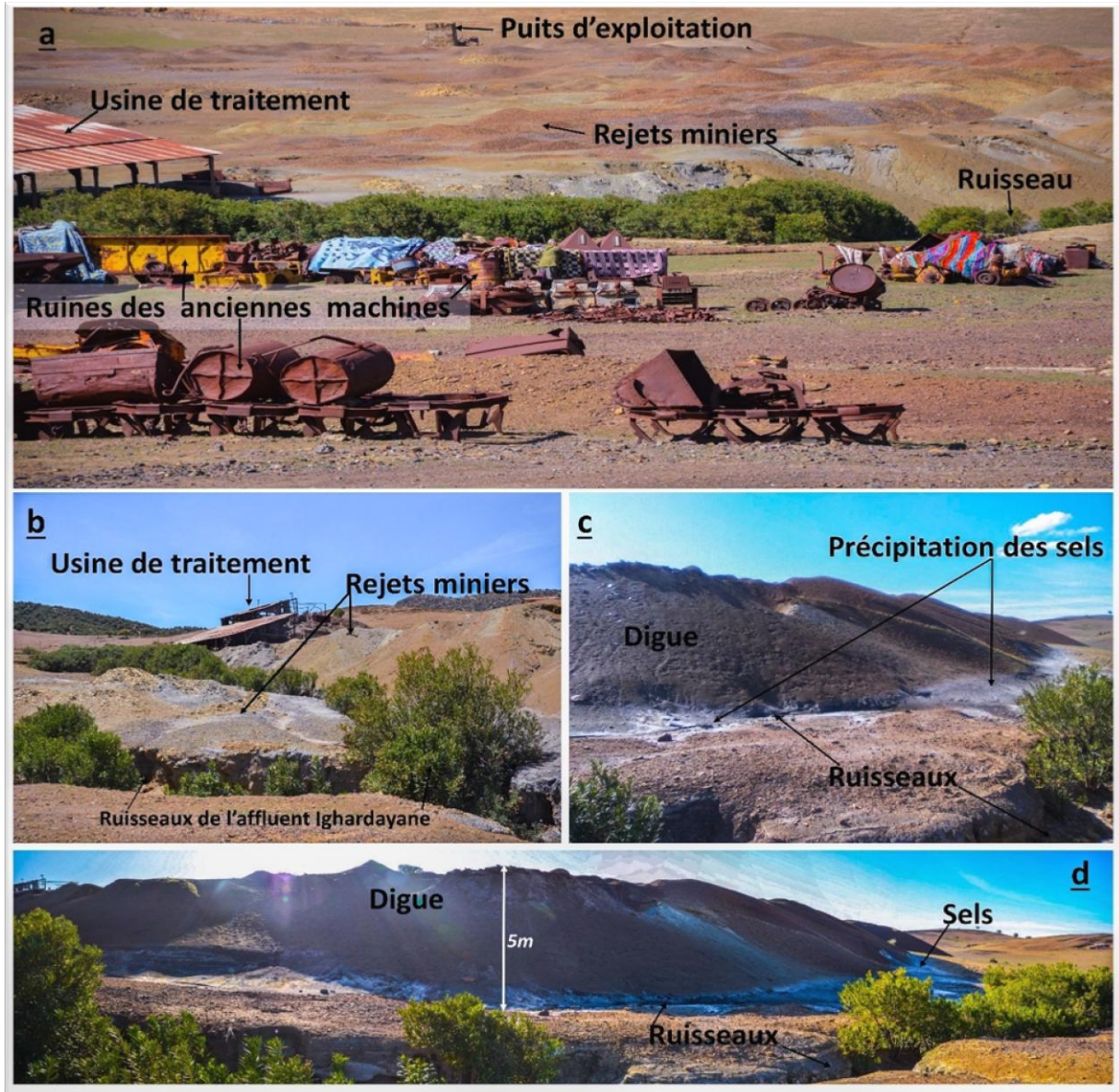
Planche I. Etat des lieux de la mine Tourtit, a : Rejets miniers et ruines de l'usine de traitements chimique et une ferraille des machines utilisé durant l'exploitation de la mine; b : rejets miniers accumulés auprès des ruisseaux hydrographiques à l'amont de l'affluent de l'Oued Ighardayane; c : phénomène de précipitation des sels minéraux issus de la lixiviation de la digue par les eaux pluviales; d : vue panoramique du diamètre de la digue Tourtit avec les ruisseaux du drainage.
